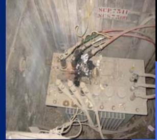
Pérdida de aislamiento de cables causados por envejecimiento o daño físico
