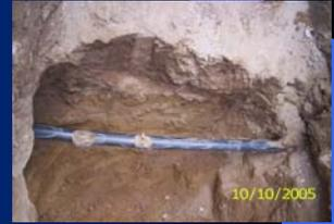
Pérdida de aislamiento de cables causados por envejecimiento o daño físico
