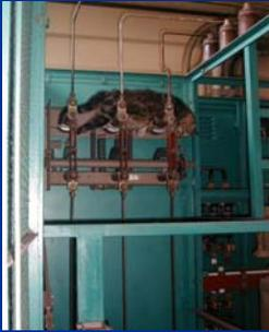
Pérdida de aislamiento de cables causados por envejecimiento o daño físico
